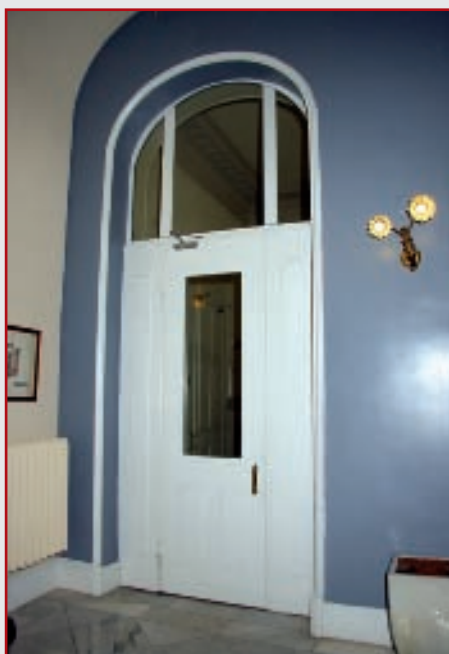
Puertas especiales RF (Resistencia ante el Fuego). A la derecha, sistema de cortina que convierte el ascensor en zona estanca ante un posible incendio.
