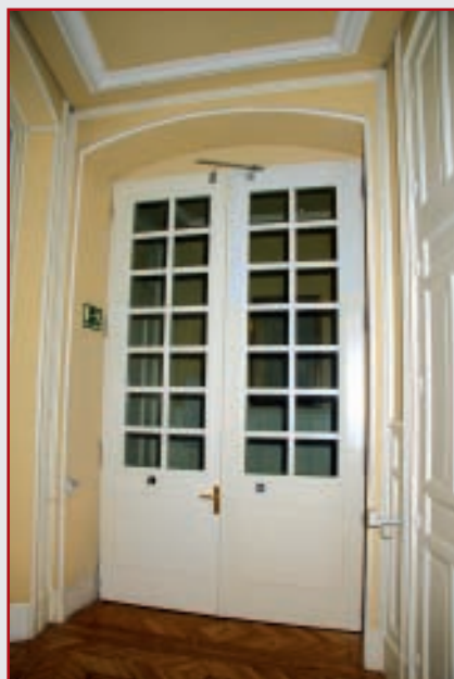
Puertas especiales RF (Resistencia ante el Fuego). A la derecha, sistema de cortina que convierte el ascensor en zona estanca ante un posible incendio.
